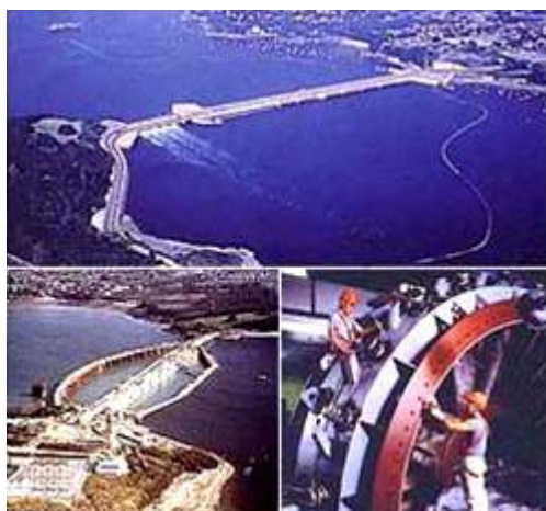
Gambar 5.25 Pembangkit listrik energi pasang surut di Pantai Estuari Rance, Perancis. (Sumber: energy-pedia.com)
