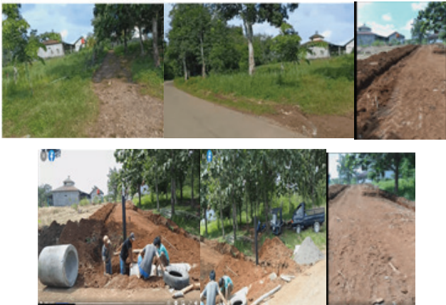
Gambar 3.25. Kondisi jalan masuk ke pesantren sebelum dan sesudah dibuatkan jalan dengan eskapator dan pemasangan gorong-gorong
