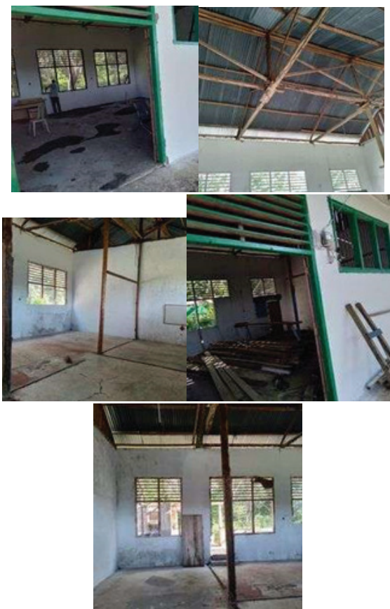
Gambar 3.27. Kondisi dalam ruang kelas sedang di renovasi
